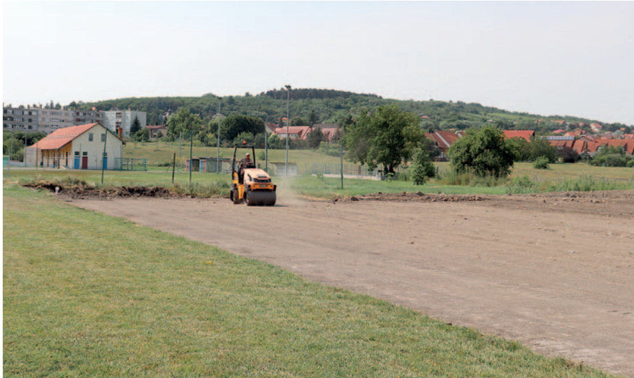
Elkezdődött a műfüves focipálya építése.
